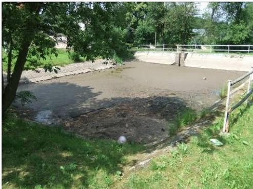
Die Ertüchtigung des Löschwasserteiches im Nebenschluss zur „Lockwitz“ in Oberfrauendorf war notwendig geworden, da der funktionelle und sicherheitstechnische Zustand nicht den geltenden Regeln der Technik entsprach sowie ein lokaler Schaden aufgetreten war.
